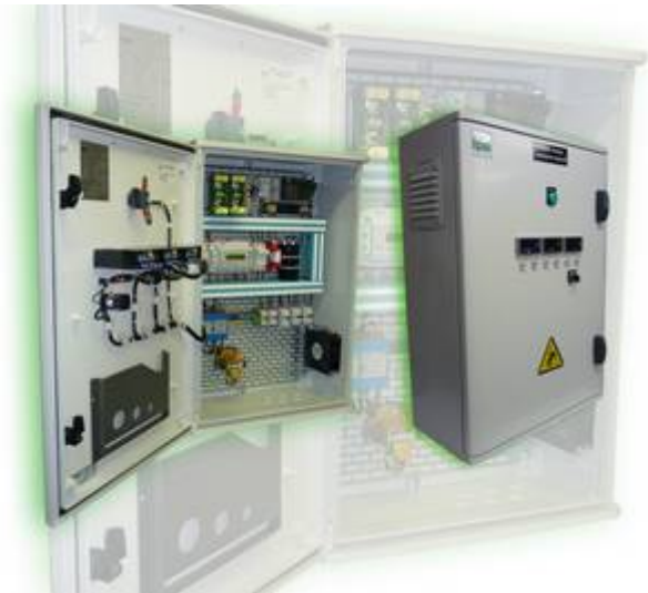
Automatic transformer rectifier
